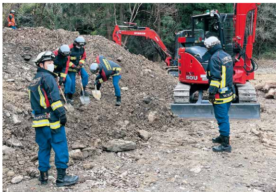
土砂を人力と重機で排出する隊員
