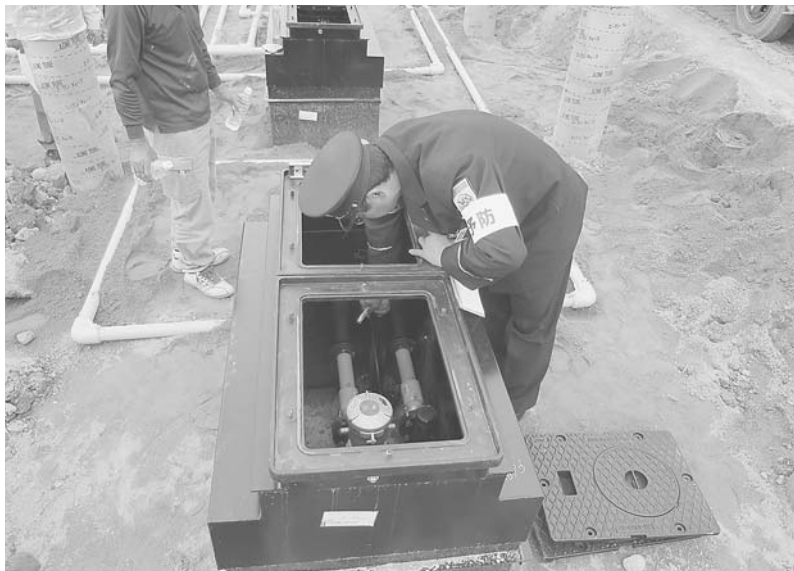
<給油所配管検査>
