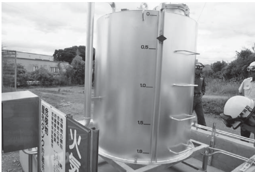
危険物屋外タンク貯蔵所の完成検査
